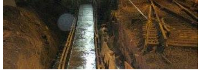
Concrete Pour North Side of Electric Box 78.
