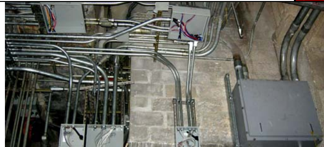
Conduits & Pull Boxes for Relocation of Conduit #62 at Track 15.
