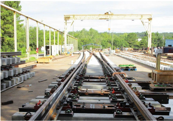
Arriba: En agosto de 2022, los miembros del equipo del proyecto observaron una prueba de fábrica de los 2 cruces/interruptores de ferrocarril fabricados en las instalaciones de Voestalpine Railway Systems Nortrak en Birmingham, Alabama.
