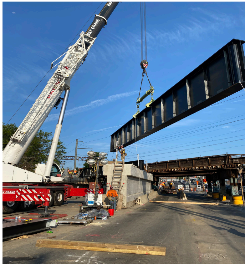
Los equipos instalan anuevas arcadas de acero en el Puente de Bronxdale Avenue, agosto de 2024
