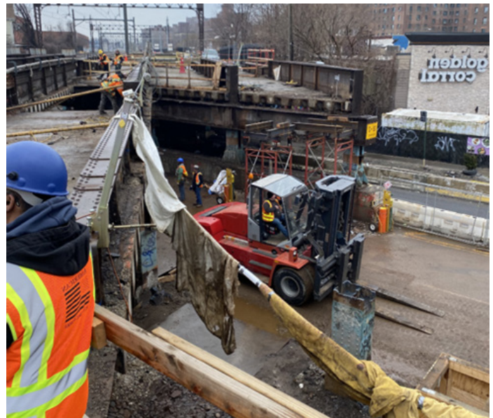
El personal trabaja en la demolición de la mitad del puente existente en el puente de Bronxdale Avenue. Febrero de 2024.
