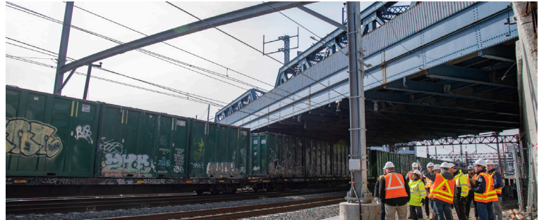
Un portal terminado en Leggett Interlocking. Febrero de 2024.
