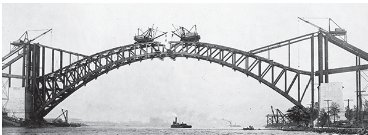
Arriba: Grúas viajeras construyen la mitad del arco principal del puente Hell Gate desde cada orilla, septiembre de 1915 Fuente: Biblioteca del Congreso
