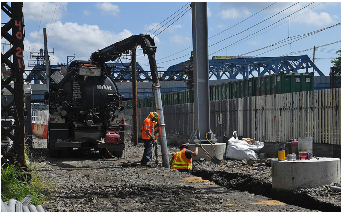
Arriba: Trabajadores excavan una zanja para cables OCS en Leggett Interlocking, agosto de 2023
