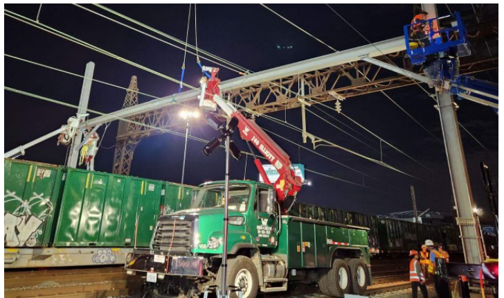
Arriba: trabajadores de la construcción de PSA instalan el portal OCS en Leggett Interlocking, octubre de 2023
