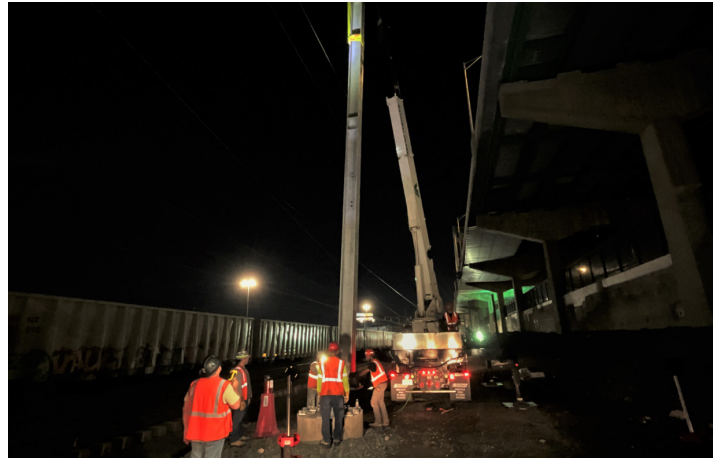
Los trabajadores de la construcción de PSA levantan el portal de la columna OCS, julio de 2023
