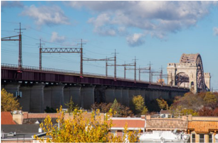
Las estructuras OCS existentes a lo largo del corredor del proyecto, noviembre de 2022
