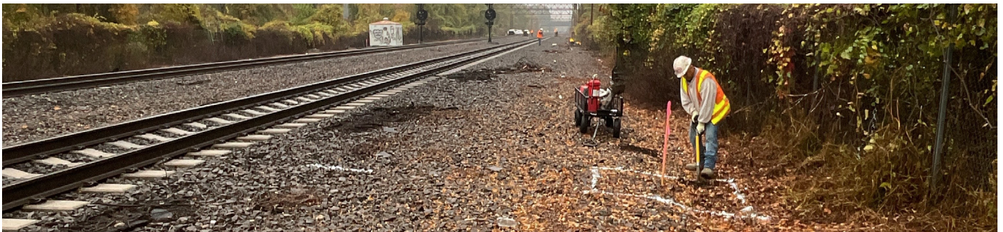
Arriba: trabajador de la construcción de Penn Station Access realizando un pozo de prueba a lo largo del derecho de paso del proyecto, 2022.
